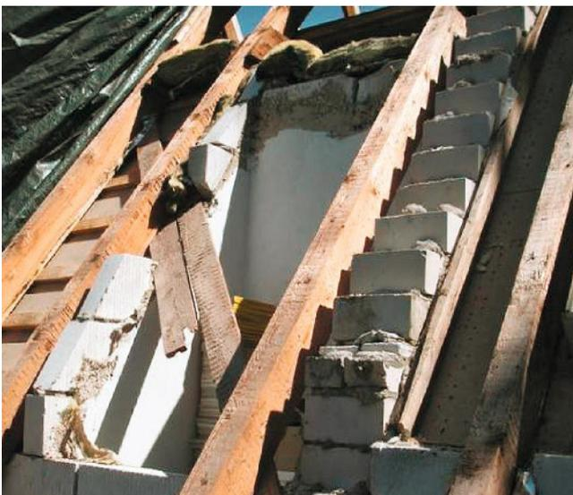
Typische Bausituation: Das Dachgeschoss ist ausgebaut, bei der Sanierung wird eine Zwischensparrendämmung geplant und beim Abnehmen der Ziegel und Lattung stellt sich heraus, dass viele Sparrenfelder bereits „besetzt“ sind.
