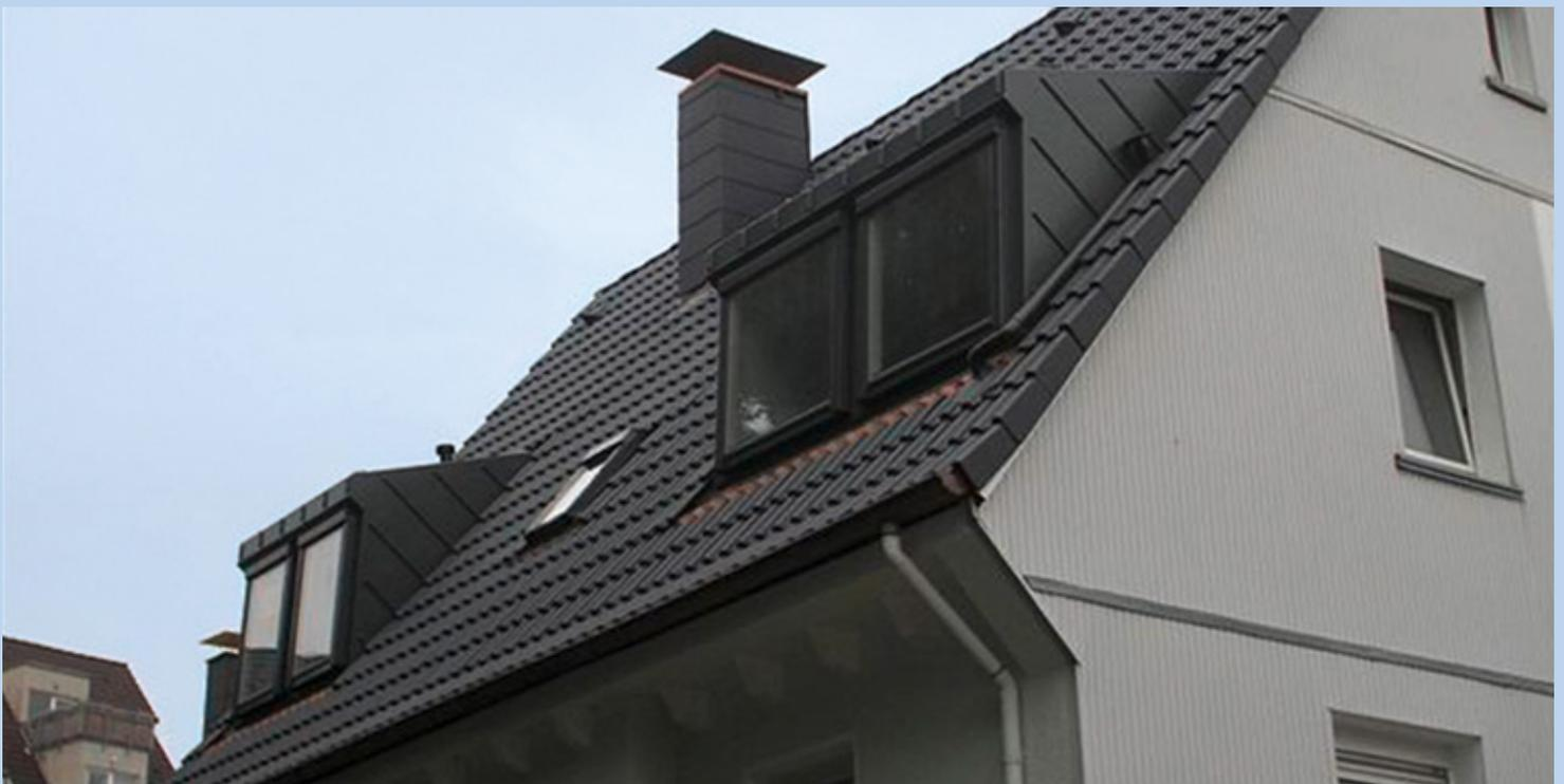
Weil Ihre Aufkeilfenster immer eine „eingebaute“ Dachneigung von 35 Grad haben, liegen sie, in Abhängigkeit von der Neigung ihres Hausdaches unterschiedlich schräg im Dach!
